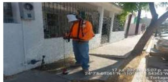
En las imágenes se muestra la revisión de tomas domiciliarias con ayuda de geófono mediante micrófono "pata de elefante". Se tratan de dos sondeos en donde se encontró la existencia de fuga.
