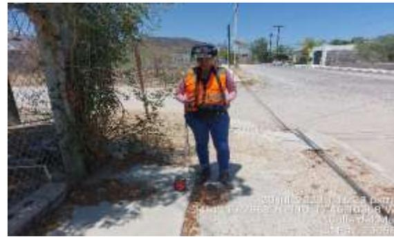
Se muestra inspección en red de distribución utilizando geófono mediante micrófono pata de elefante, Se determina que no hay fuga.
