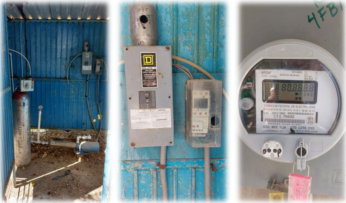
Se muestra caseta de cloración, tablero de control y medidor de energía eléctrica de CFE.
