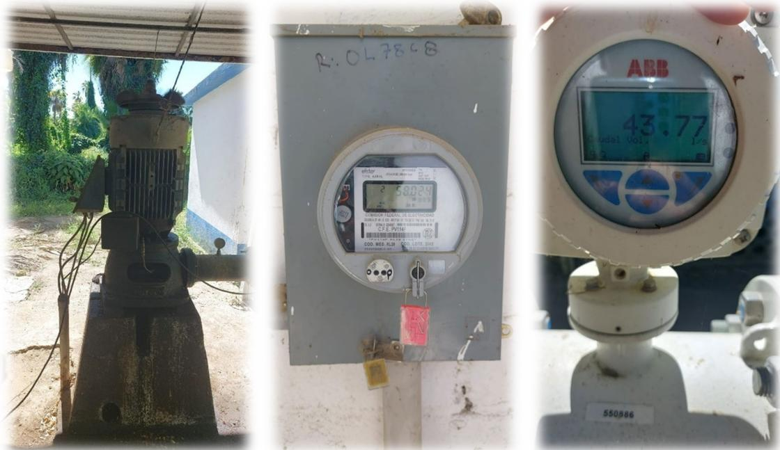
Se observa motor del sistema de bombeo así como medidor de luz y medidor de flujo electromagnético.
