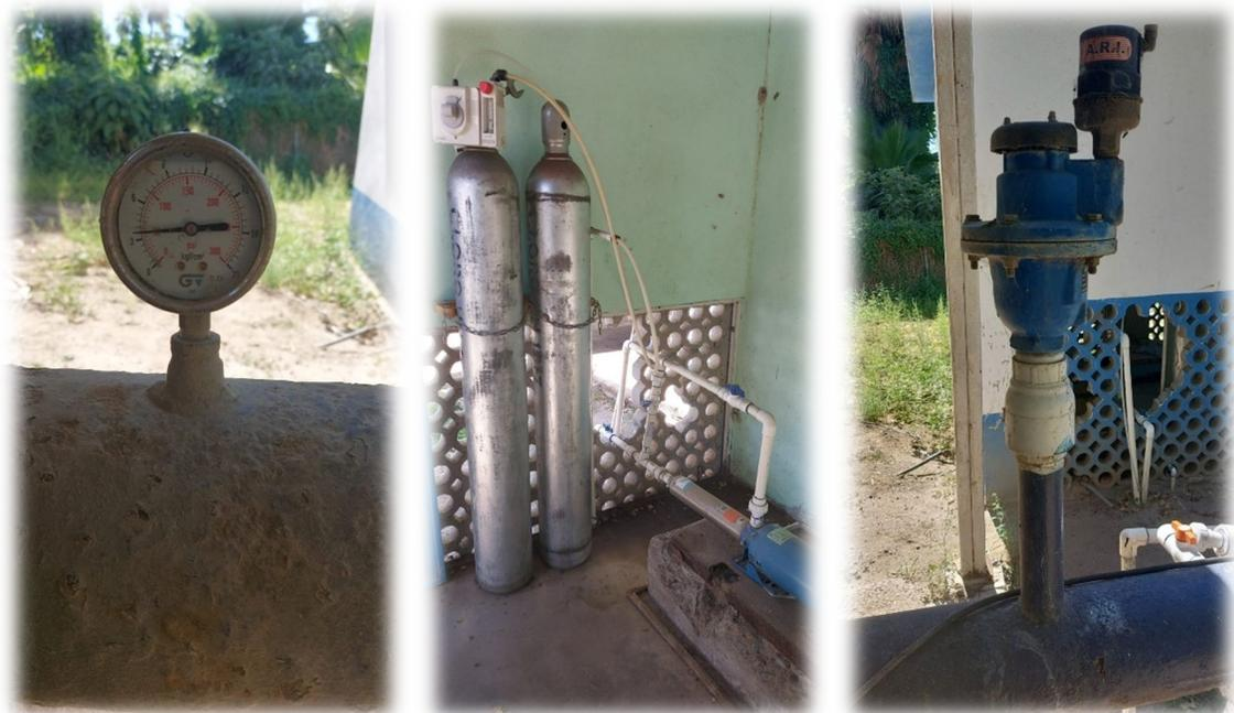
En las imágenes se muestra manómetro, sistema de cloración, y válvula de admisión y expulsión de aire.
