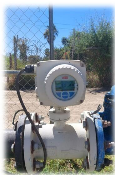
En las imágenes se pueden observar manómetro, válvula y medidor de flujo electromagnético en operación.
