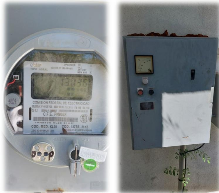
Se muestra medidor de energía eléctrica de CFE así como tablero de control dentro del sistema de bombeo.
