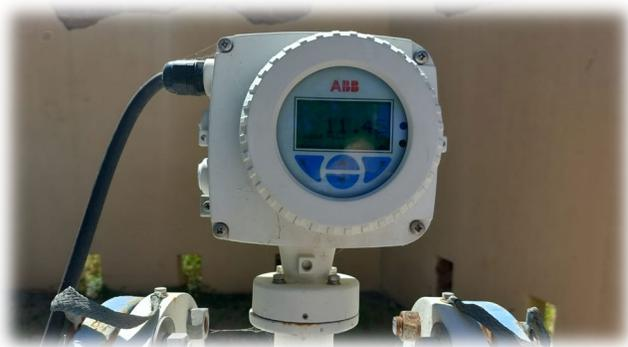
Se muestra descarga hacia la red de distribución así como el medidor de flujo electromagnético.
