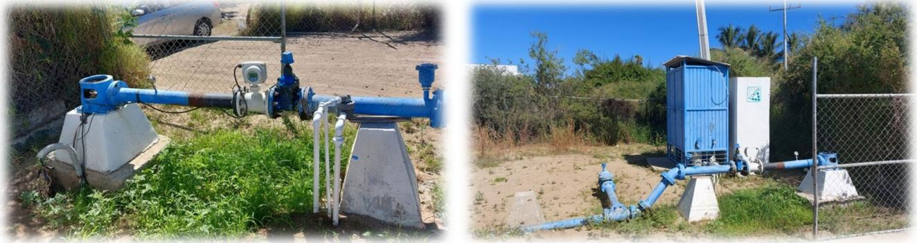
Se muestra arreglo general del tren de descarga así como vista general de la caseta de cloración.
