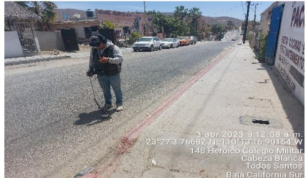
Se muestra inspección en red de distribución utilizando geófono mediante micrófono pata de elefante, Se determina que no hay fuga.
