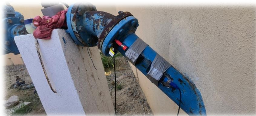
En la imagen se muestra la ubicación de los transductores del caudalímetro ultrasónico en el tren de descarga de la obra de captación.
