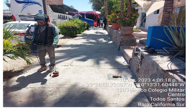
En la imagen se muestra la revisión de toma domiciliar con ayuda de un geófono mediante micrófono "pata de elefante".
