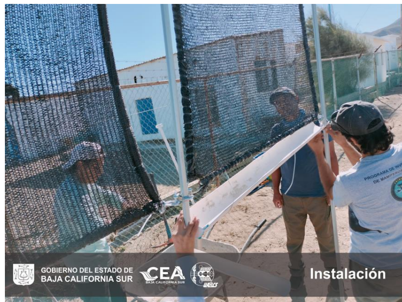
Figura 9. Instalación de Neblinómetro.
