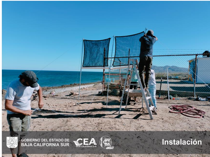
Figura 8. Instalación de Neblinómetro.
